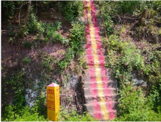
照片 3.2-30 管道采取的挡土坎措施
