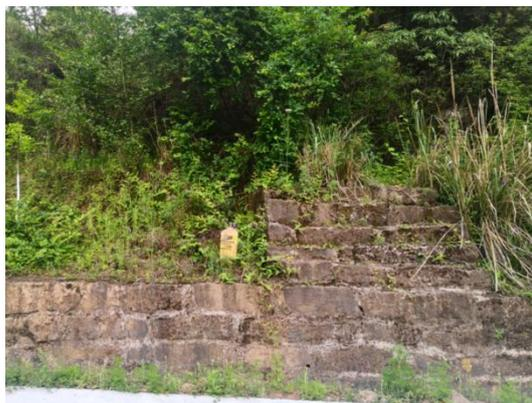
照片 3.2-33 管道防护措施—挡土墙
