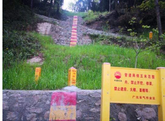
照片 3.2-31 管道采取的挡土坎措施
