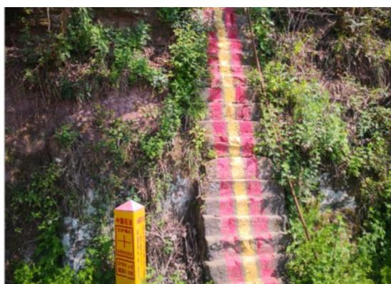
照片 5.2-9 管道防护措施—挡土墙
