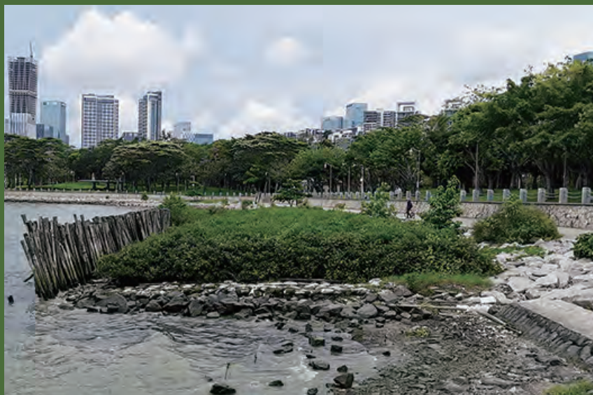
图 7 深圳湾采用石块建造围堰以抬高滩涂高程
