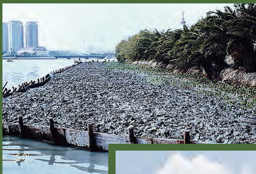
图 6 厦门筓筓湖湖心岛采用木板建造的临时围堰
