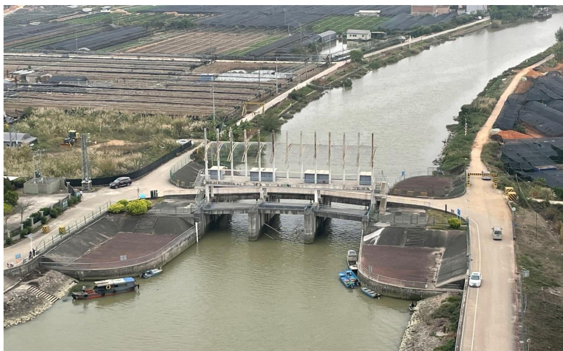
图 5.1-11 四沙水闸现状照片
