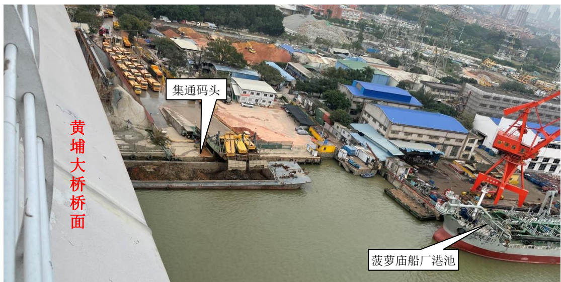
图 5.1-2a 集通码头现场照片一（镜向东北）
