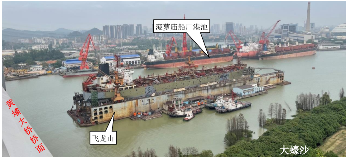
图 5.1-5 菠萝庙船厂照片（镜向东北）
