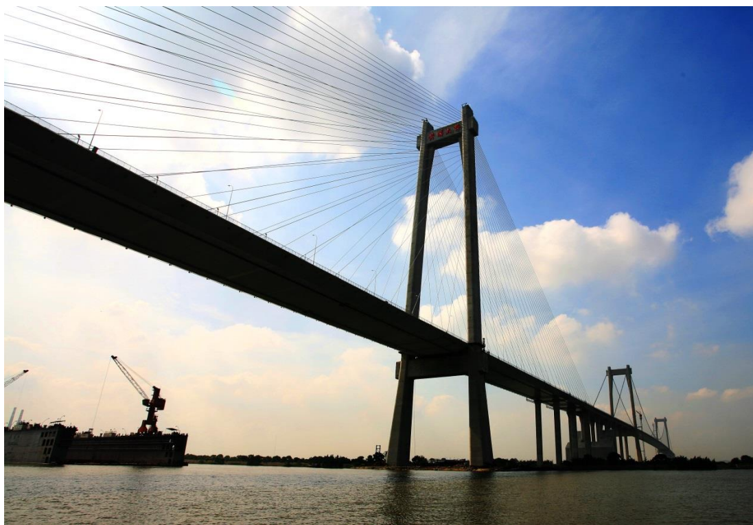
图 2.2-3a 黄埔大桥现状照片（北汉斜拉桥）
