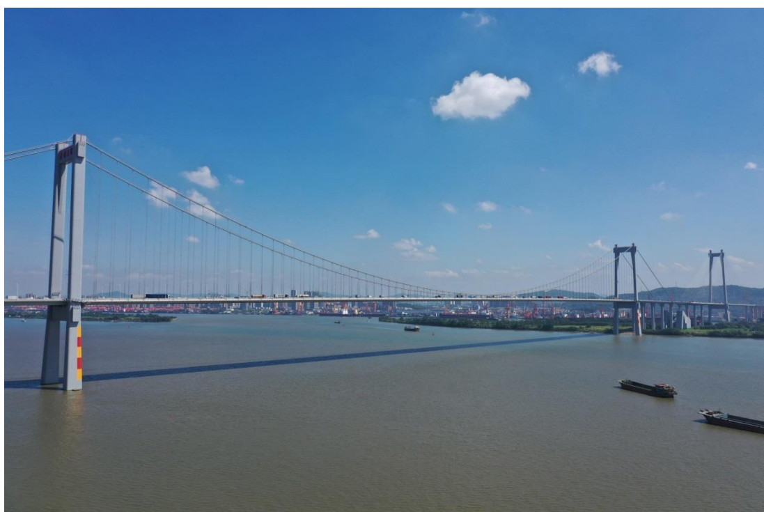
图 2.2-3b 黄埔大桥现状照片（南汉悬索桥）
