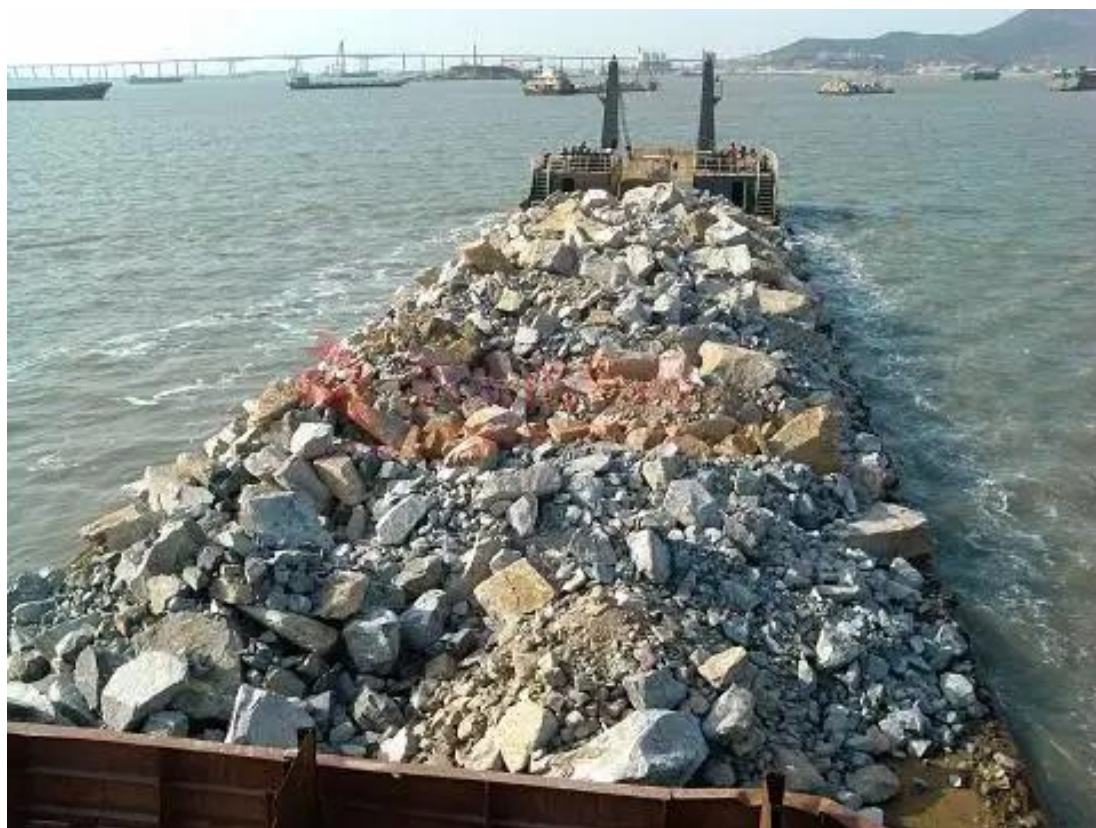
图 2.3-17 驳船填基床块石
