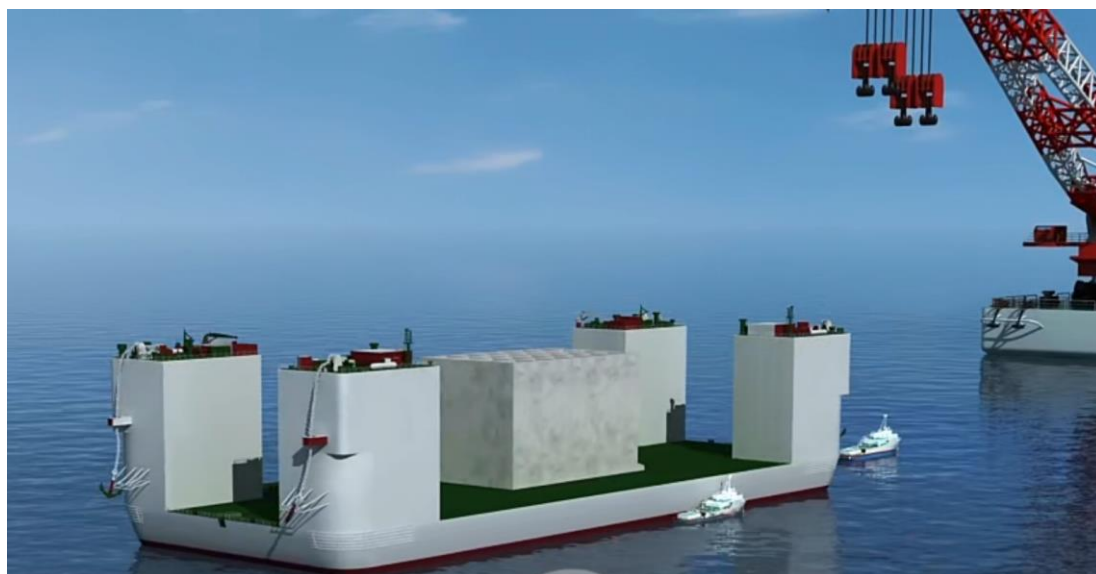
图 2.3-18 半潜驳驳运沉箱至指定安装区域
