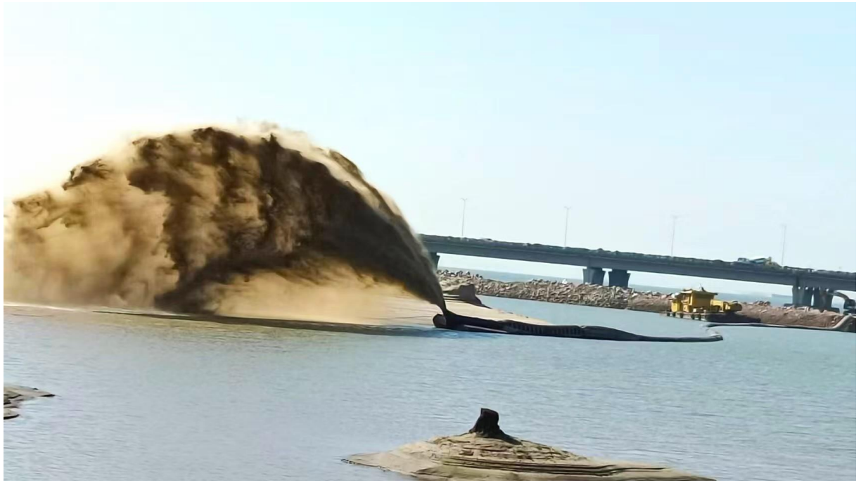
图 2.3.1-4 吹填照片
