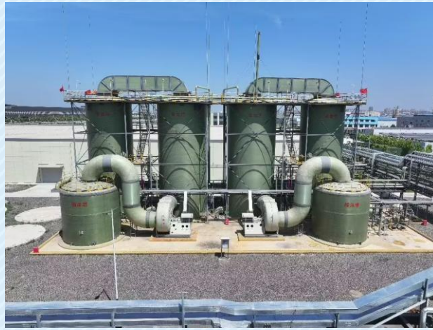
唐山海港经济开发区蓝仓海水淡化浓盐水提溴工程
