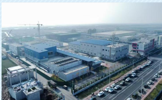
唐山海港经济开发区申港海水淡化工程
